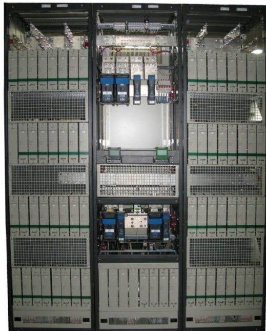
Рисунок 7.1 - ЭПУ в составе двух стоек СУЭП-3 и ЩТР
